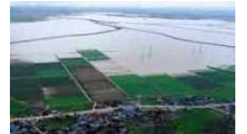
集中豪雨による農地の湛水被害
