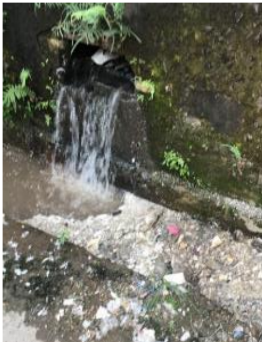
<リサイクル施設から未処理のまま放流される排水>
