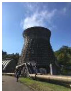
▲松川地熱発電所
