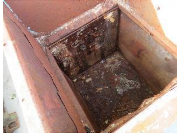
ベラー投入口内部
