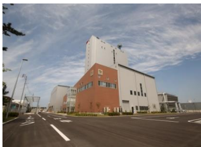
秋田県木質バイオマス発電事業
