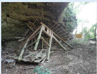
老朽化しき損した堂宇の修理
