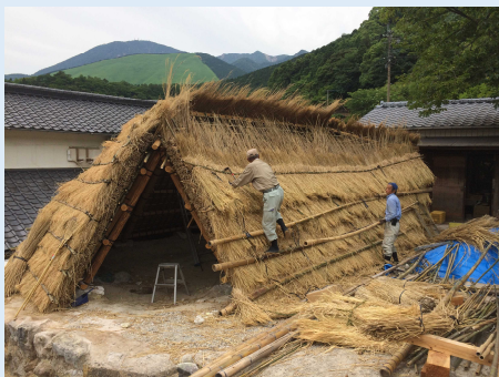
熊本地震で礎石や石積みがずれた湯の花小屋の職人による復旧
