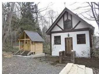
循環し尿処理槽
