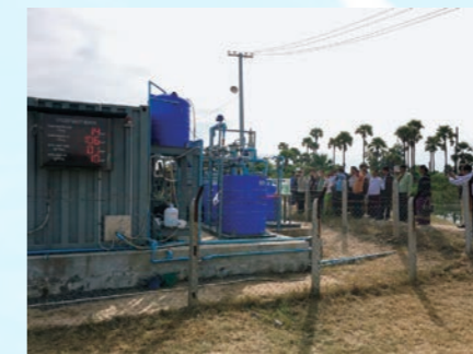
実証運転に用いた排水処理装置
