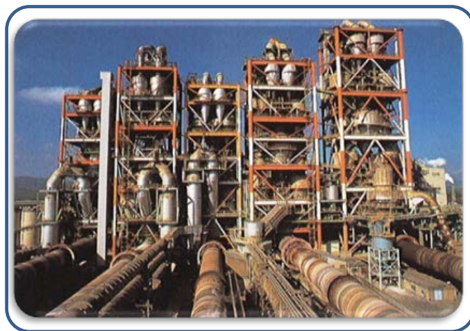
図 1.5.1-4 セメント製造施設の例
