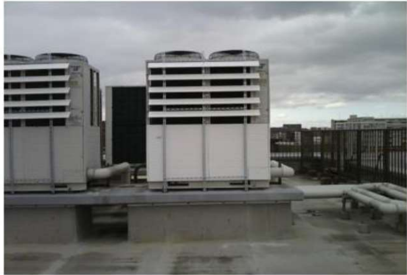
【試験施工写真】
