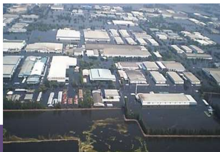
タイ ロジャナ工業団地の浸水状況 （2011年10月～11月）
