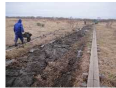
水抜き水路の埋め戻し
