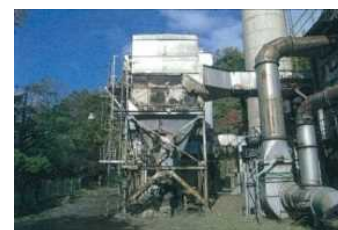
老朽化した廃棄物処理施設の更新
