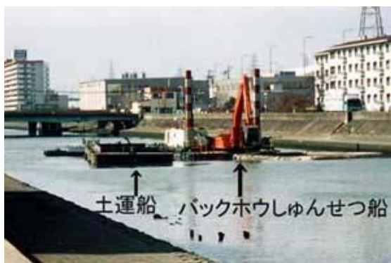
(バックホウ浚渫：水深が浅い場合)
