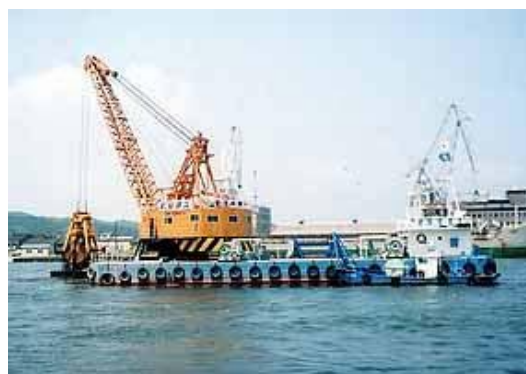
(グラブ浚渫：水深が深い場合)
