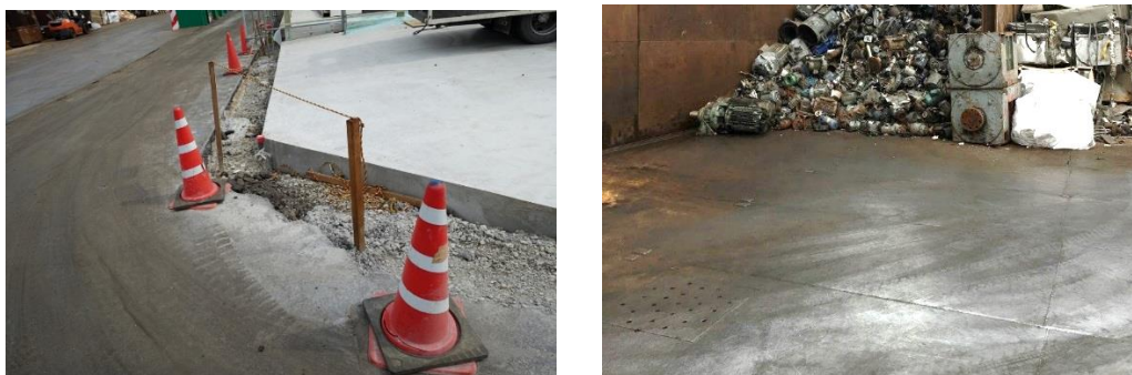
図 3 地下浸透防止策の事例 (左：ヤード床面はコンクリート（350mm）で舗装。写真は工事中のもの) (右：コンクリートの上に鉄板を敷設)
