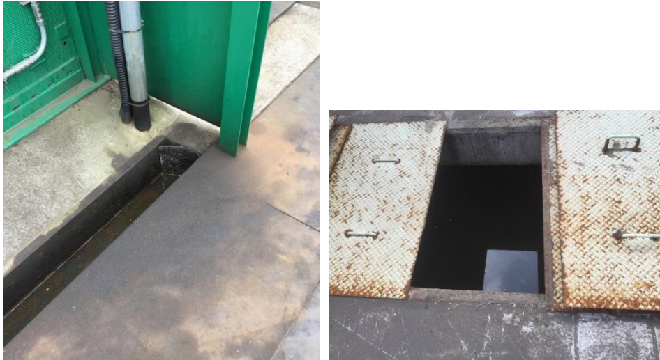
図 7 汚水の流出防止策の事例 (左：ヤード周辺に排水溝を設置、右：油水分離槽の設置)
