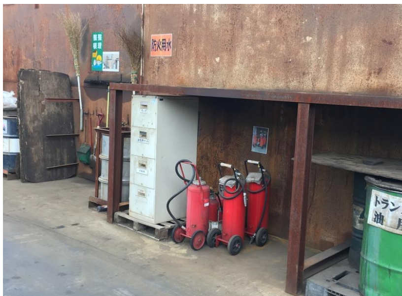
図 17 消火器の設置事例
