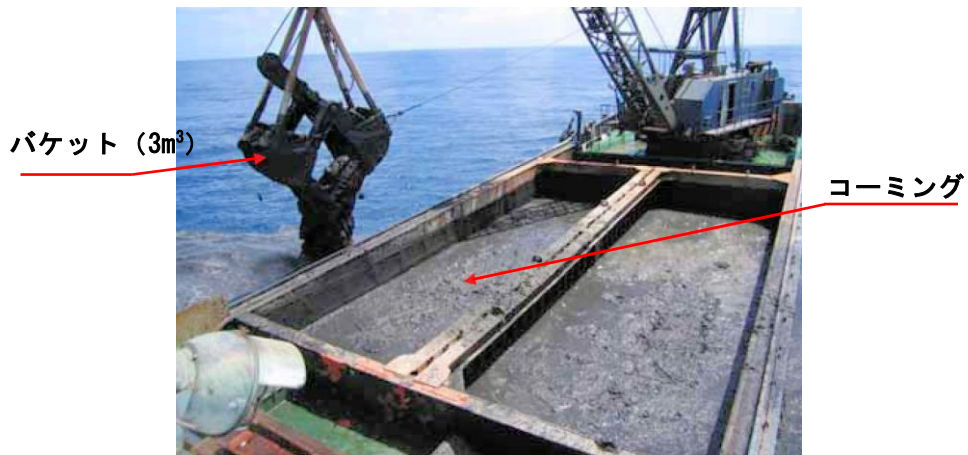
図1-① 浚渫土排出状況
