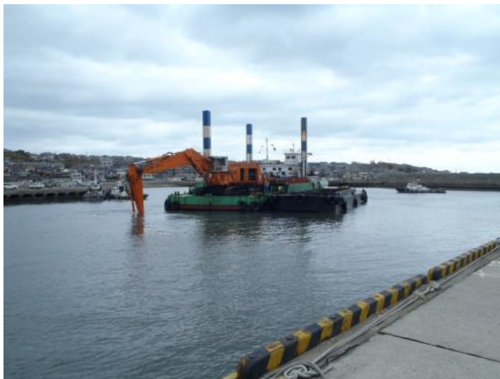
写真はバックホウ浚渫船。土砂は土運船に積み込む。
