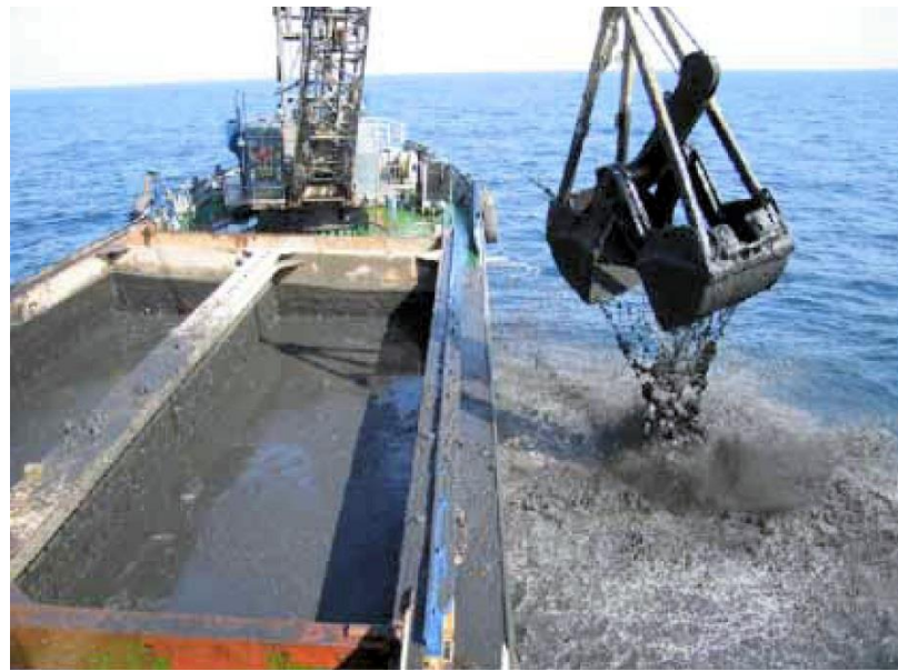
浚渫土砂排出状況
