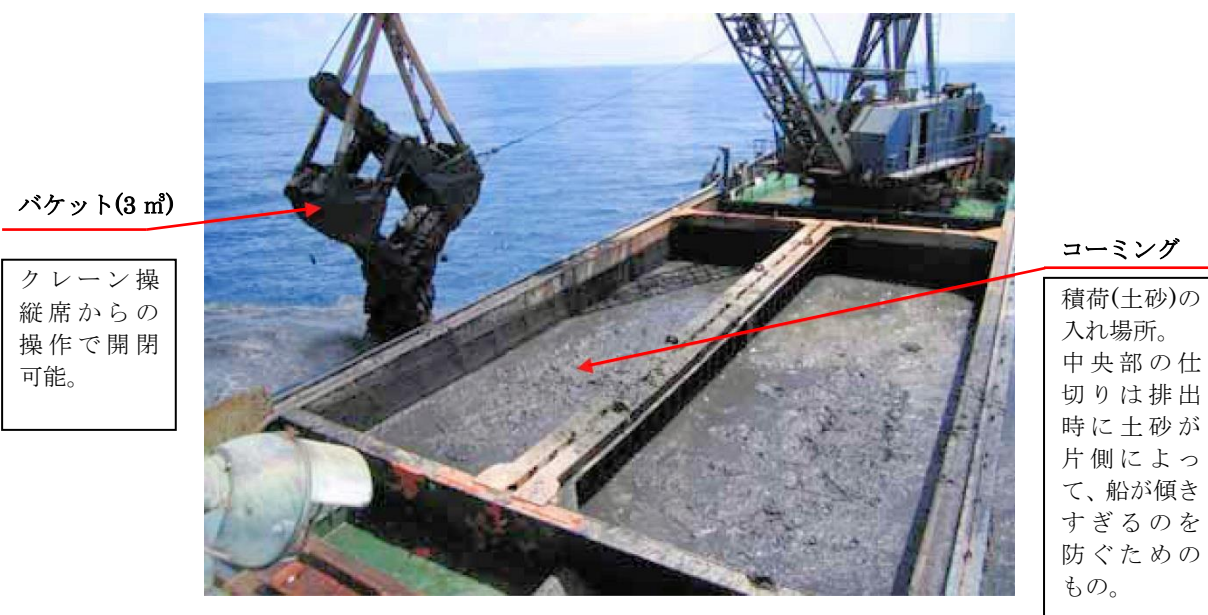
浚渫土砂排出状況
