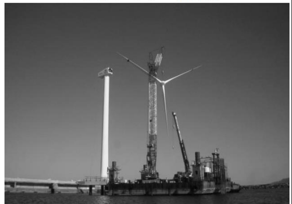
ローター設置状況
