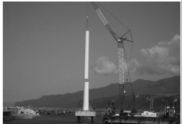
タワー設置状況
