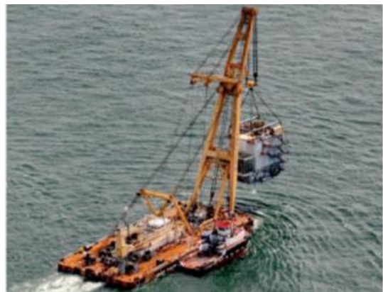
運搬中の変電所 (吊り運搬)
