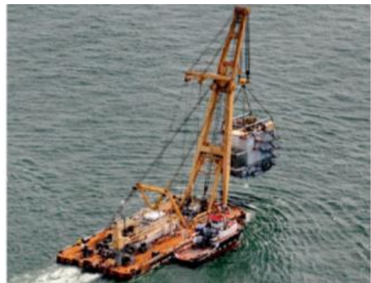
運搬中の変電所 (吊り運搬)
