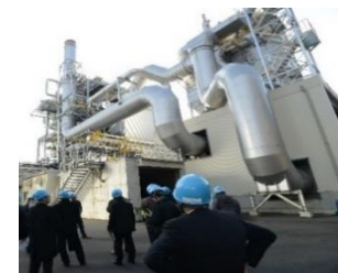
木質バイオマス発電所
