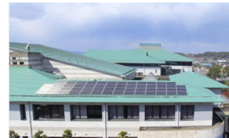
太陽光発電設備 (熊本県御船町)
