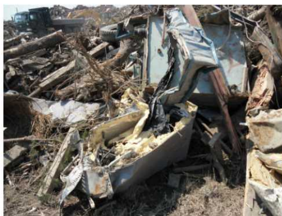
津波等により流失した断熱材
