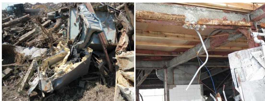
津波により流された断熱材
