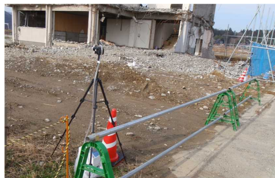
損壊建築物近傍での測定例
