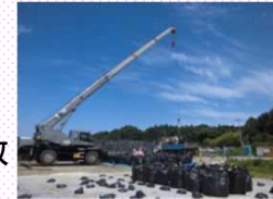
除去土壌等の搬出の様子
