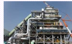
仮設焼却炉の建設状況(対策地域内廃棄物)
