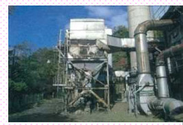
老朽化した廃棄物処理施設の更新
