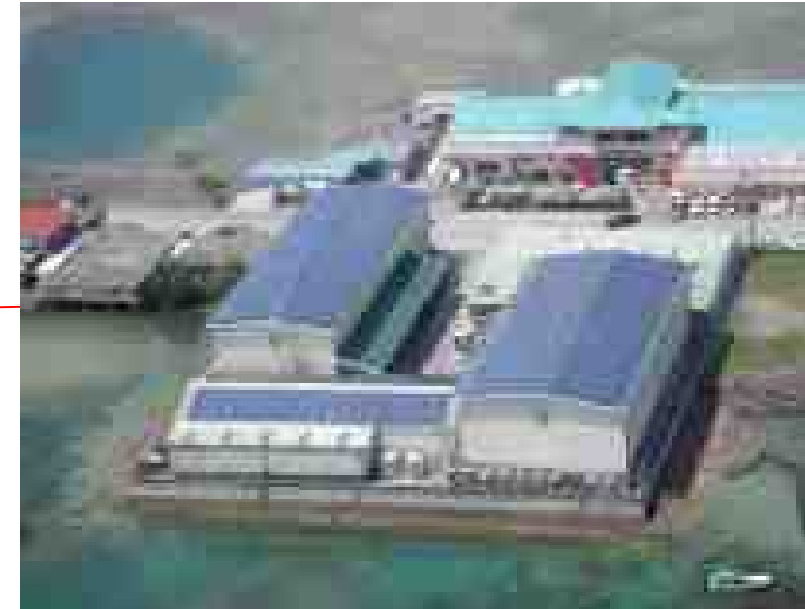
サブプロジェクト1 (倉庫): 220.5kW
