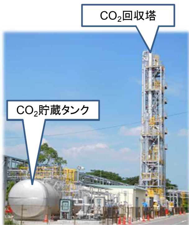
二酸化炭素分離回収設備（最大10トンCO 2 /日） （環境省補助対象設備）
