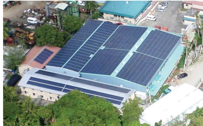
食品倉庫屋根への設置状況
