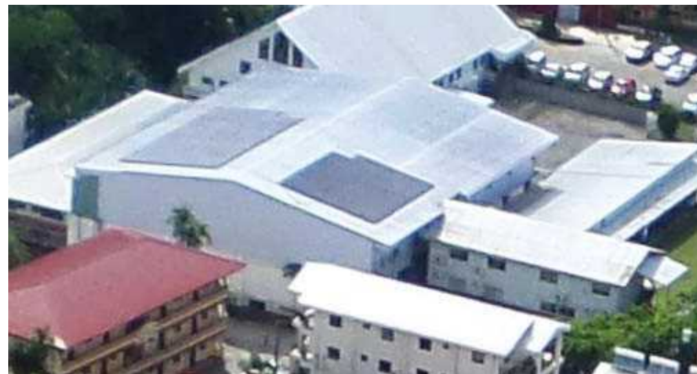
小学校の屋根への設置状況
