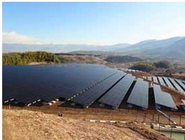
【大面積を被覆する太陽光パネル】
