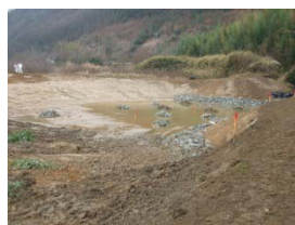
整備直後（平成22年）
