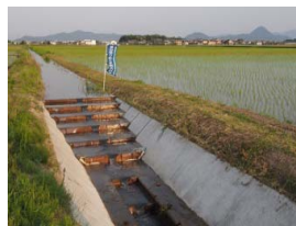
排水路堰上式魚道
