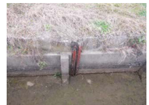
堰上げ板をはめる溝
