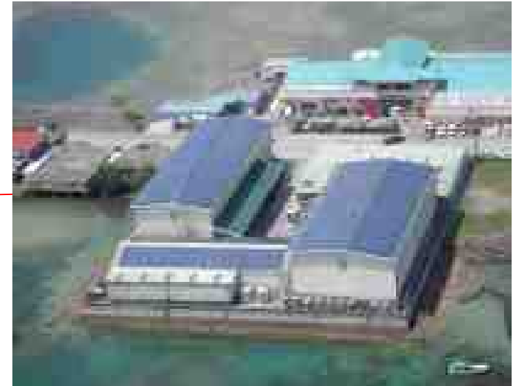
サブプロジェクト1 (倉庫): 220.5kW
