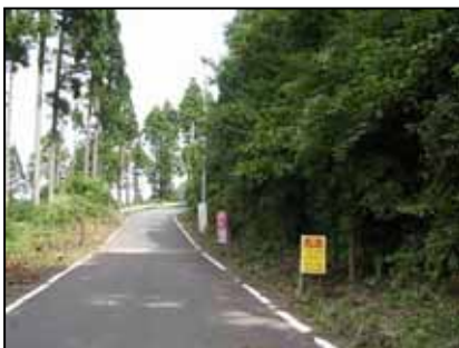
写真：舞鶴半島海岸線道路
