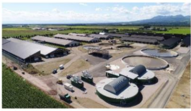
バイオガスプラント
