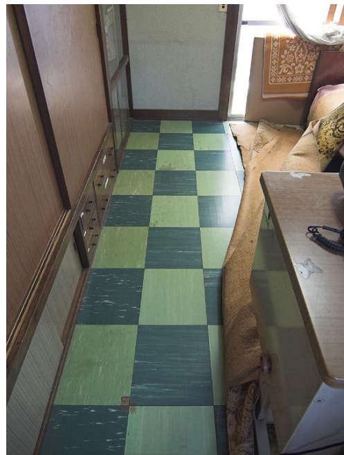
④石綿含有ビニル床タイル
