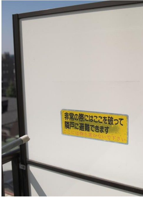
⑦石綿含有フレキシブル板
