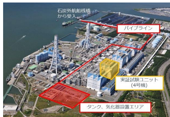
15 図9 碧南火力発電所におけるアンモニア混焼実証
