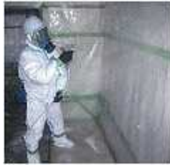
図 3.28 養生シートへの散布
