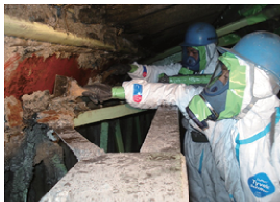
図 3.64 手工具（ヘラ）を使用した石綿含有吹付け材の除去作業
