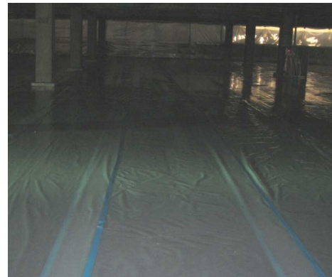
図 3.24 床面の隔離養生例 (2重張り)
