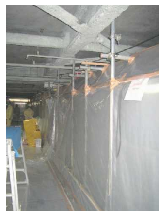
図 3. 16 同上施工区画(内部側、右外側が車路)
