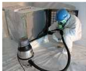
図 3.38 HEPA フィルタ等の清掃
