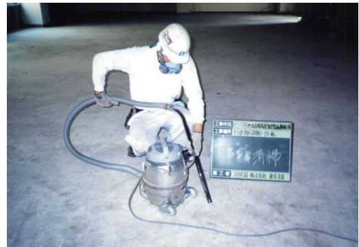
図 3. 115 清掃 高性能真空掃除機使用例
