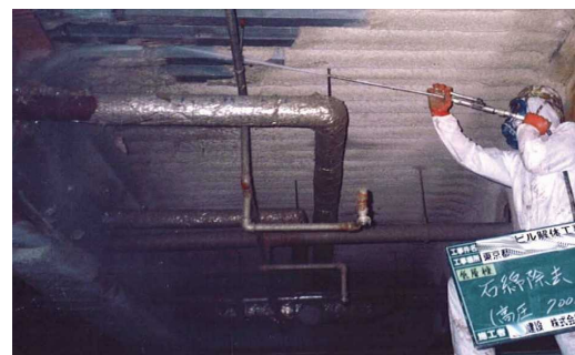
図 3.56 ウォータジェット工法の例
