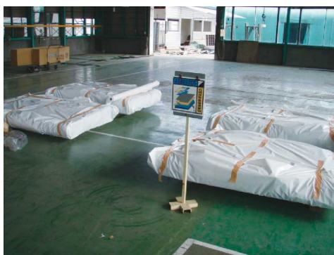
図 3. 116 石綿含有成形板廃棄物の保管例
