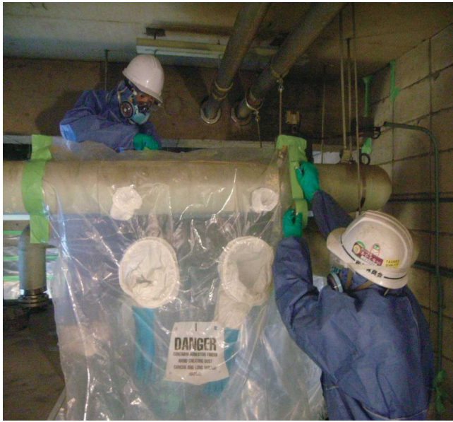
図 3.86 グローブバッグの例
