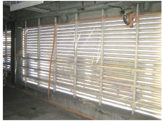
図 3.38 外壁の隔離例（ガラスの手前をプラスチックシートで隔離）
