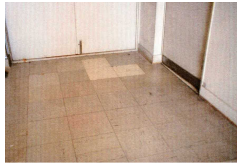
図 3. 107 石綿含有ビニール床タイル
