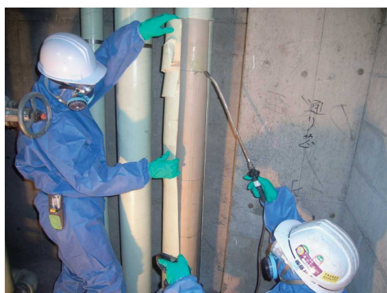
図 3.80 保温材の取外し
