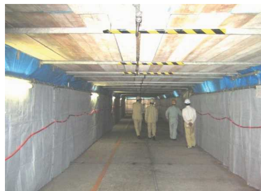
図 3. 14 駐車場ビルにおける施工区画(車路の両側及び上部吊足場が施工区画)
