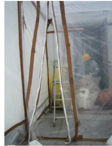
図 3.46 セキュリティゾーン各室のジッパ式仕切りの例
