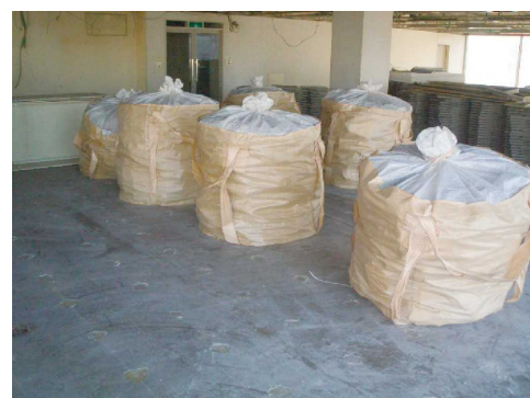
図 3. 116 石綿含有成形板廃棄物の保管例
