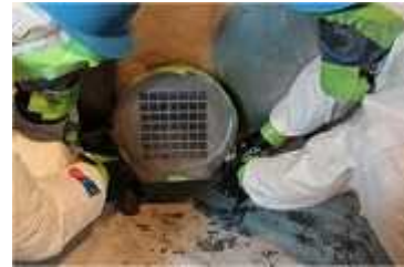
図 3.30 集じん・排気装置の排気口をプラスチックシート等で封鎖
