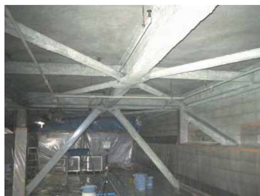
図 3. 15 同上施工区画の内部側
