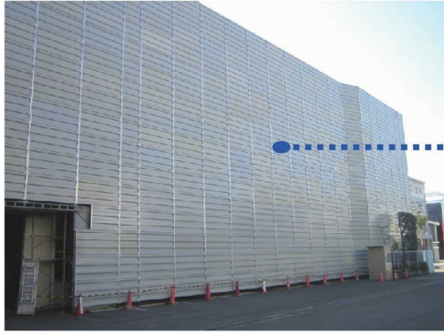
図 3.28 建屋周囲に設置した、通常の解体工事で使用する防音パネル（枠組足場に取り付け、内部の石綿除去工事を視覚的にも遮断）
