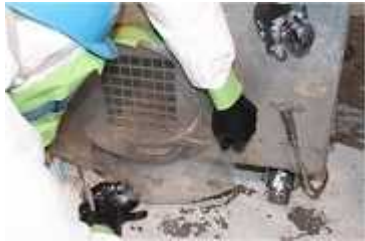
図 3.30 集じん・排気装置の排気口をプラスチックシート等で封鎖
