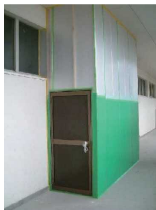
図 3. 17 教室前廊下の施工区画(外部側)
