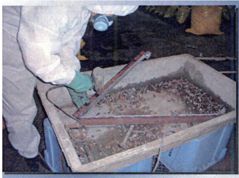
図 3. 118 掻き落とし除去作業の例
