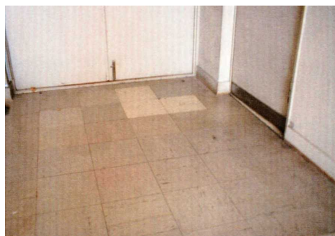
図 3.107 石綿含有ビニール床タイル
