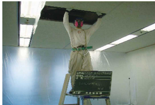
図 3.110 天井石綿含有成形板の除去例
