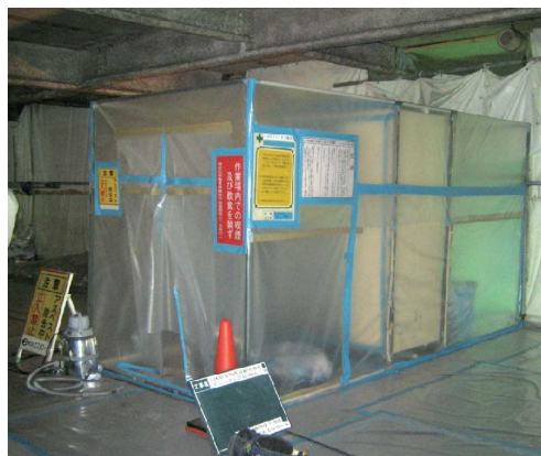
図 3. 40 セキュリティゾーン外観
