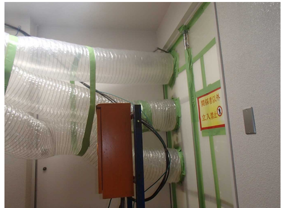
図 3.53.3 排気ダクトと隔離の取合い（隙間を完全に封鎖）
