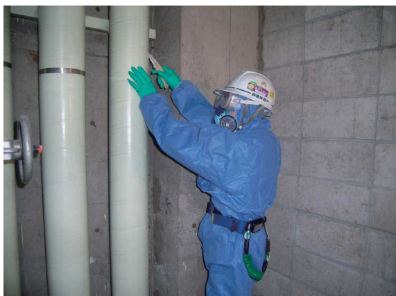
図 3.79 保温材被覆撤去
