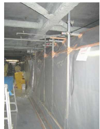
図 3. 16 同上施工区画(内部側、右外側が車路)
