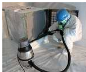
図 3.38 HEPA フィルタ等の清掃
