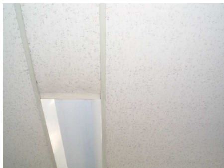
図 3.106 石綿含有ロックウール吸音天井板
