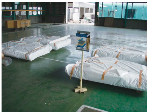
図 3. 116 石綿含有成形板廃棄物の保管例
