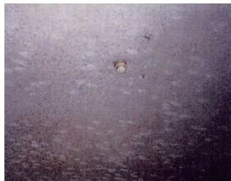
（吸音・断熱材：機械室の壁・天井）
