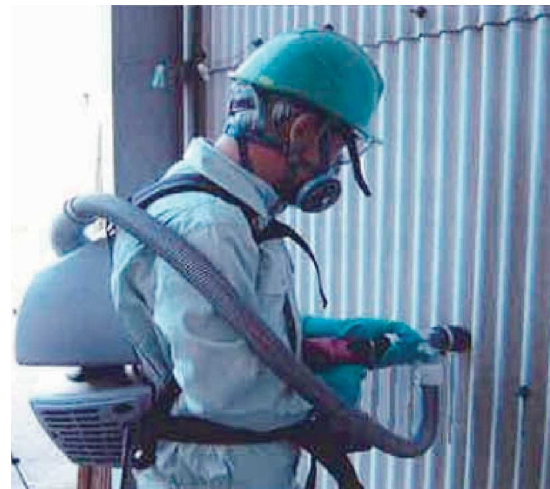
図 3. 111 機械工具による切断例
