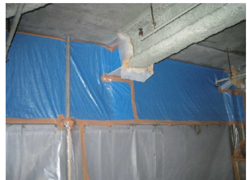
図 3.25 壁面の隔離養生例 (作業場内側)
