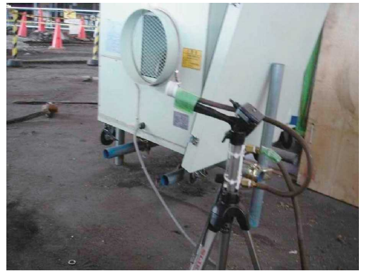
図 3.93 環境測定（作業中）
