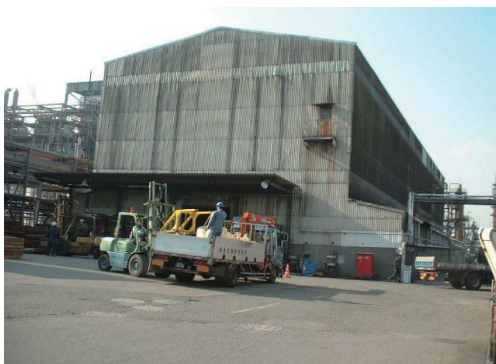
図 3. 105 石綿含有スレート波板
