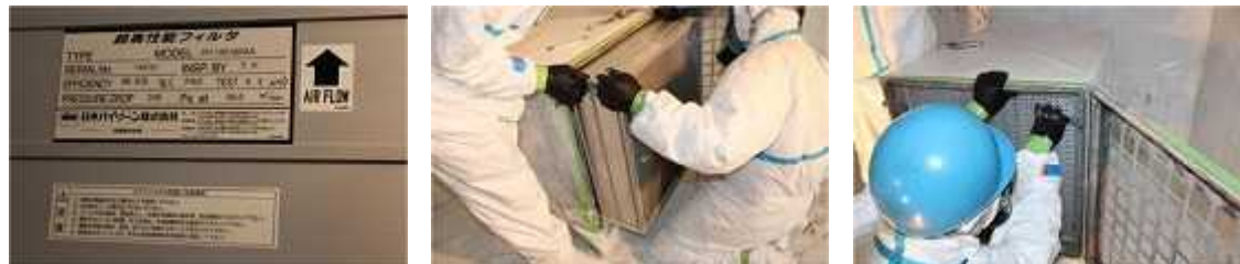
図 3.41 フィルタの取り付け
