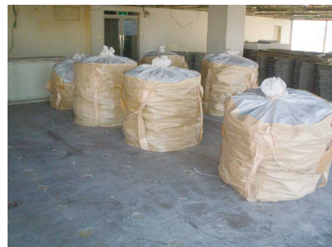
図 3. 116 石綿含有成形板廃棄物の保管例
