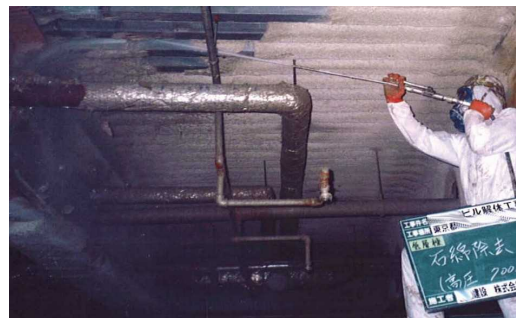
図 3.56 ウォータジェット工法の例
