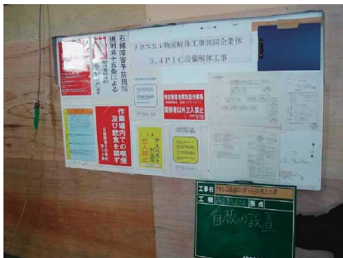
図 3.87 屋外蒸気配管用における掲示
