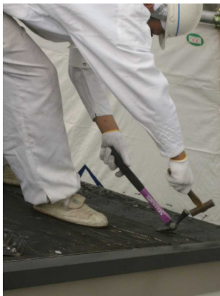
接合固定部分の取外し
