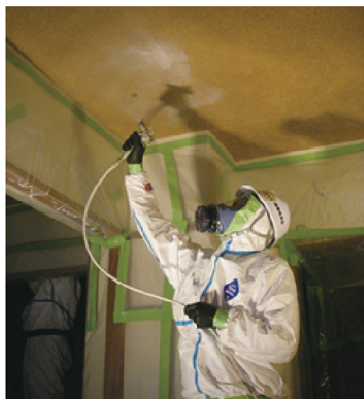
図 3. 63 粉じん飛散抑制剤の散布による湿潤化
