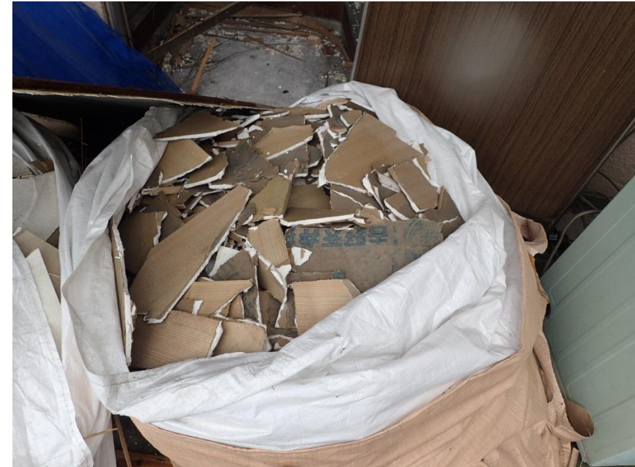
ボールで叩かれたボード類
