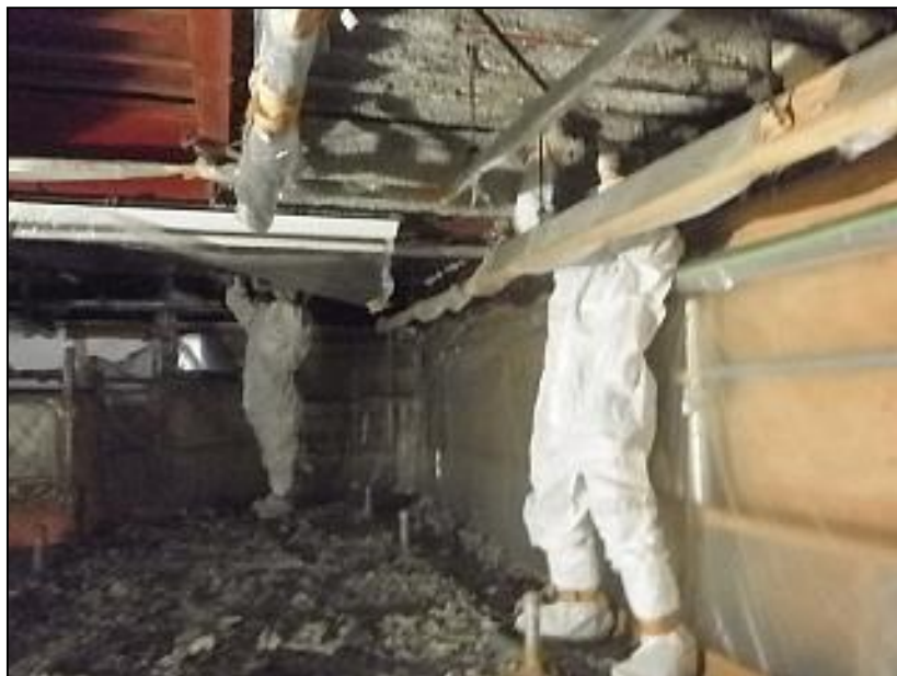
僅かな吹付け石綿も残さず除去
