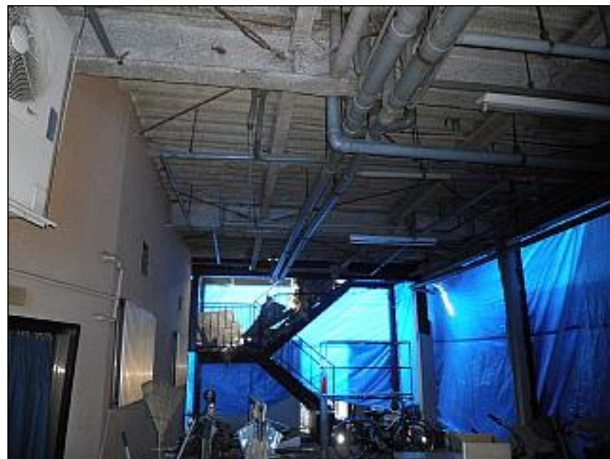
1階天井は吹付け石綿が露出状態
