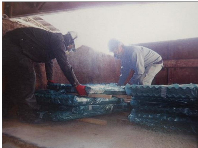
移動・処分時の飛散防止のため、シートで梱包
