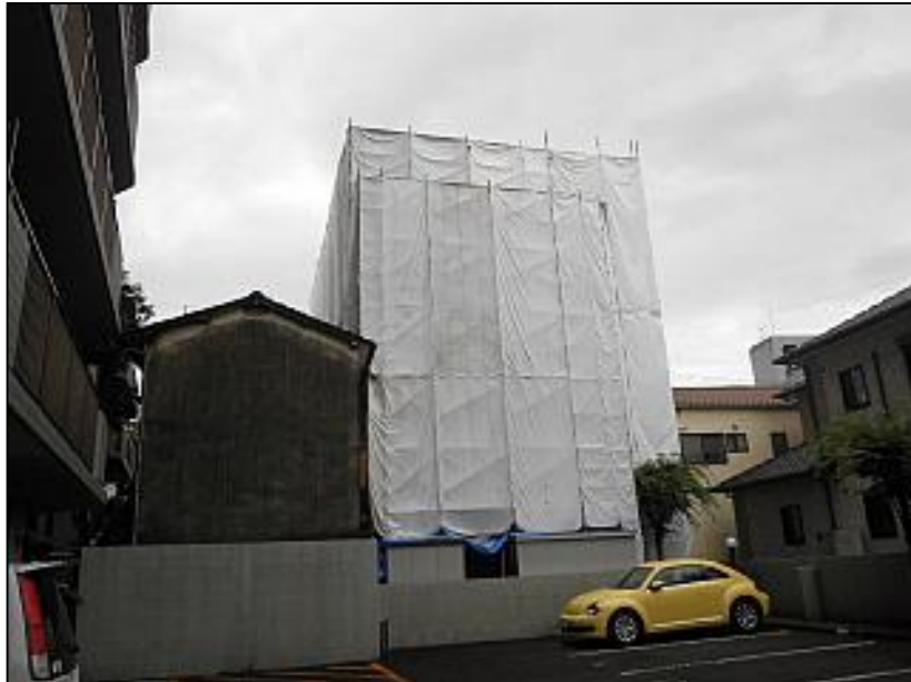
早急に足場を組み、全面シート設置
