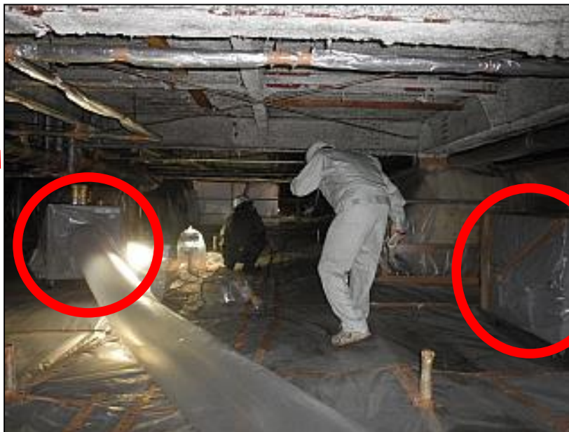
集塵機も適切な位置・台数で設置
