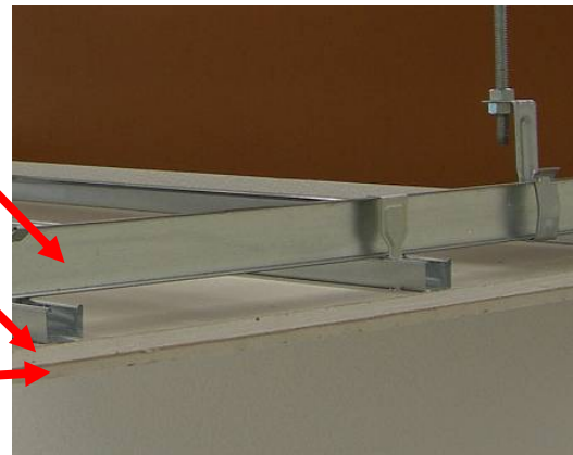
ロックウール吸音天井板捨て張り工法のモデル
