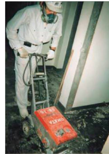
ビニル床タイルの撤去
