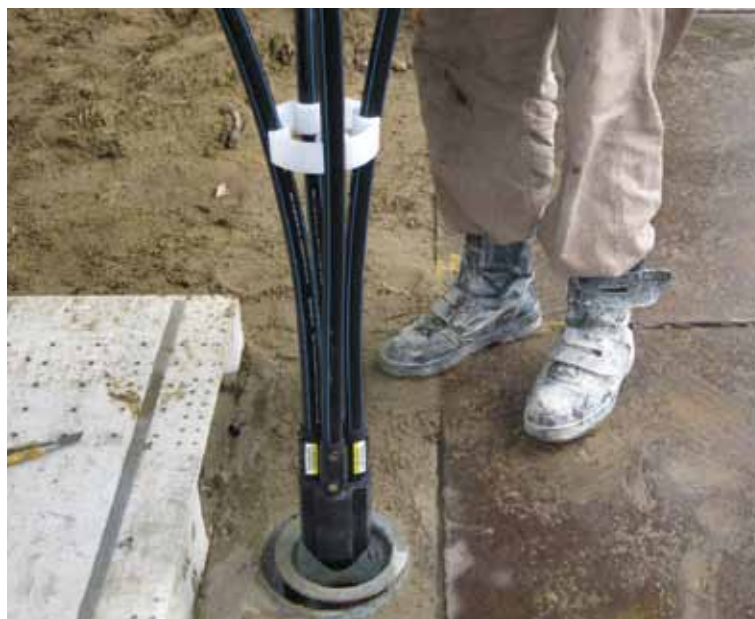
分岐管方式の地中熱交換器
