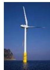
浮体式洋上風力発電
