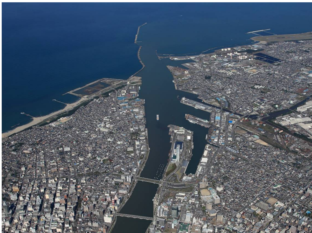
新潟港（西港地区）の現在の状況
