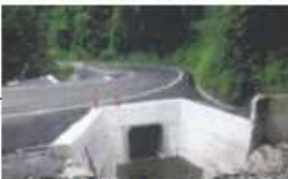
排水工の設置
