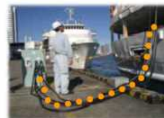
電力供給設備
