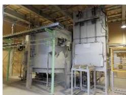
<Li-ion電池リサイクル設備>
