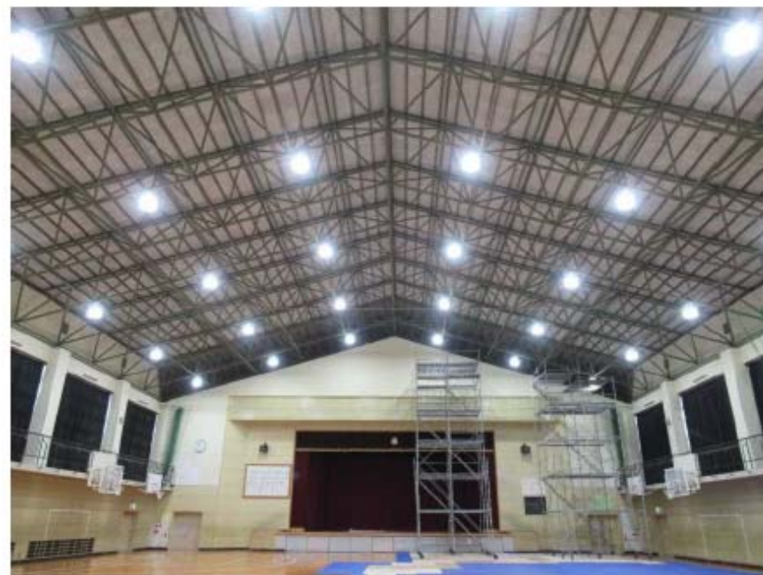
中学校体育館へのLED照明導入
