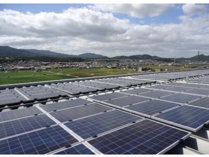
弐号機(105.6kw) 甲陸市民共同発電所
