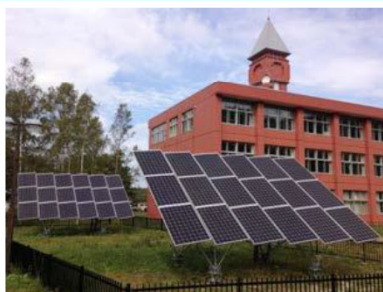
避難所に設置した太陽光発電
