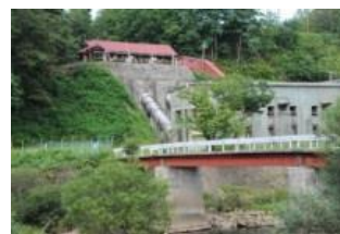
▲町内水力発電所
