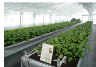
▲地中熱ヒートポンプ使用農業ハウス
