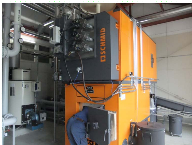
三刀屋健康福祉センター 給湯設備・空調(冷暖房)設備
