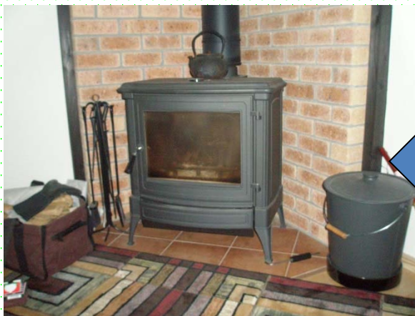
利用(薪ストーブ・ボイラー)
