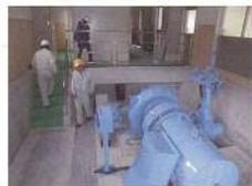
今年7月に大規模リプレース工事が竣工し、再稼働した西栗倉水力発電所「めぐみ」の内部にある発電機と水車。
