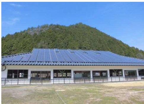
2014年3月稼働 48.84kw(年間予想発電量50,000kwh)
