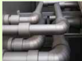
余剰冷温水や熱等の相互利用のための導管の敷設
