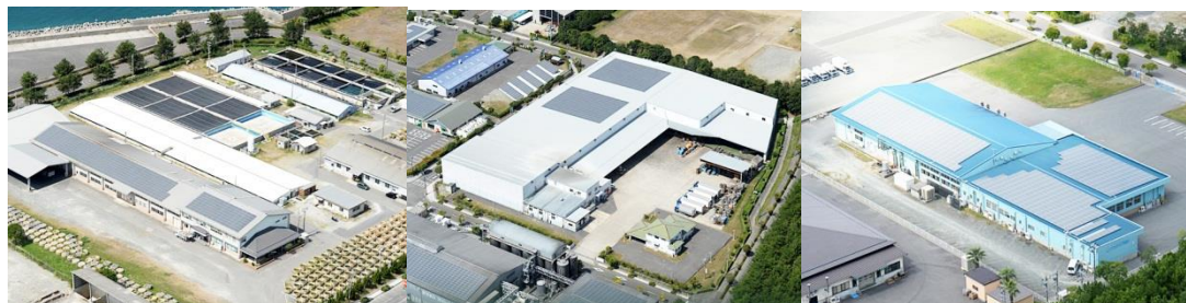
図 事業実施体制及び設備の設置状況
