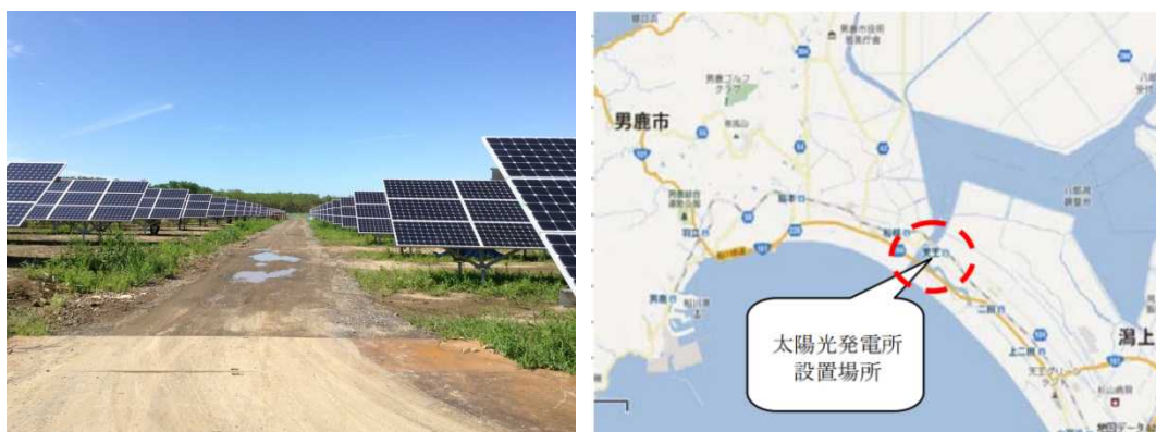
図 現地“エコエコランド”の様子（秋田県潟上市、設備容量 2,225kW）
